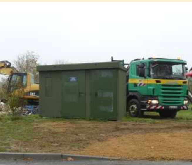
de l'ancien transformateur !
